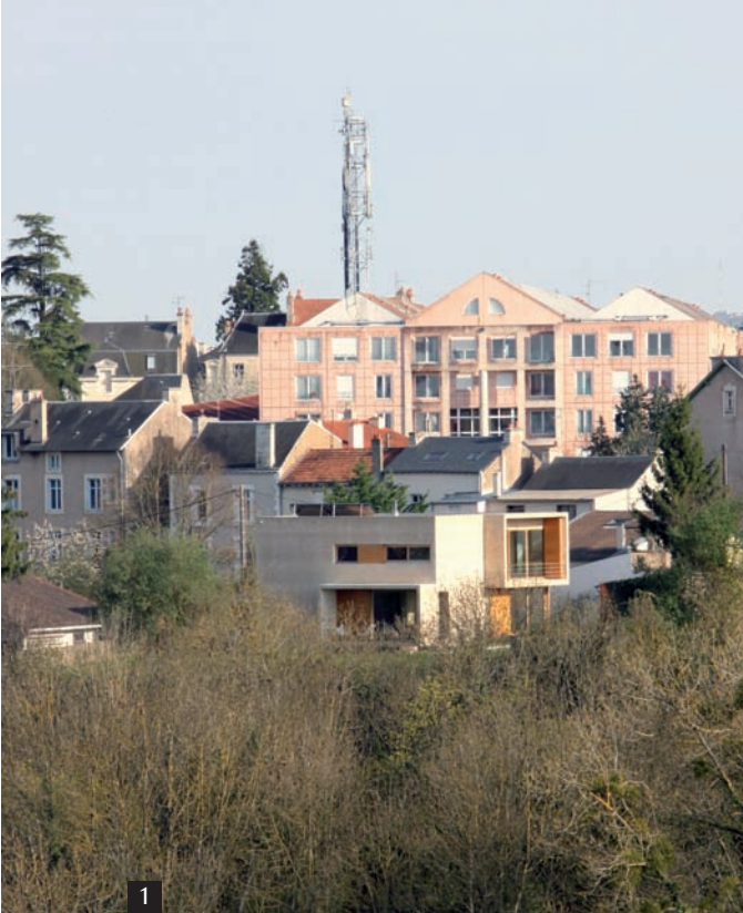
→ 1 • Réalisée en béton de site, la construction attire l'attention par son volume cubique et sa teinte ocre-jaune. 2 • De larges ouvertures prolongent l'habitat vers le jardin.
